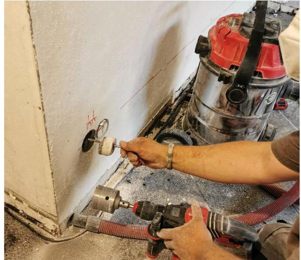
Während des Bohrens müssen zwischendurch die Mauerstücke aus der Bohrkronen entfernt werden, dazu einfach den Staubsauger nah an die Bohrkronen halten.
