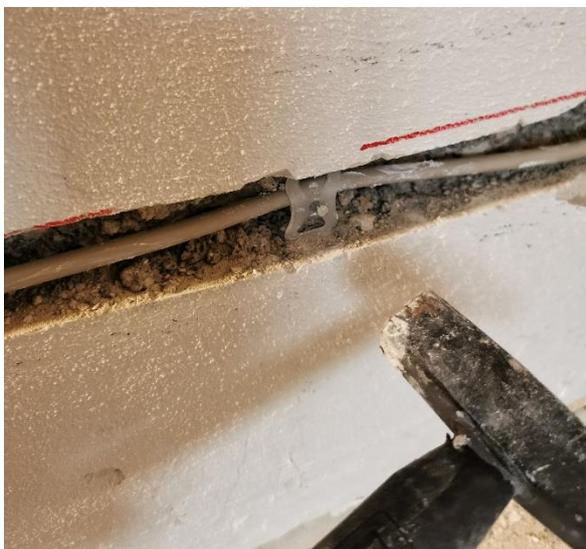
**Tipp:** Die aus einer Steckdose, Schalter oder einem elektrischen Gerät herausführende Leitung sollte nach maximal 10 cm mit einer Schelle befestigt werden. In der Waagerechten darf der maximale Schellenabstand 25 cm betragen, in der Senkrechten 40 bis 50 cm.
