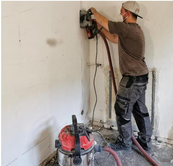
Dafür benutze ich die [Mauernutfräse TE-MA 1700](#), alternativ kann auch eine Schlitzfräse verwendet werden. Die Schnitttiefe der Fräse kann man auf 30 mm stellen, so hat man genügend Platz für das Kabel und die Befestigung.
