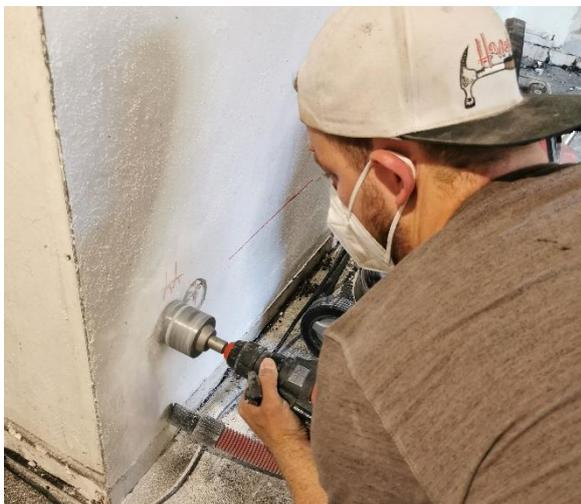
Danach kann der Zentrierbohrer herausgenommen werden, um ohne den Bohrer auf die gewünschte Tiefe der Dose zu bohren (4,6 cm oder 6,6 cm).
