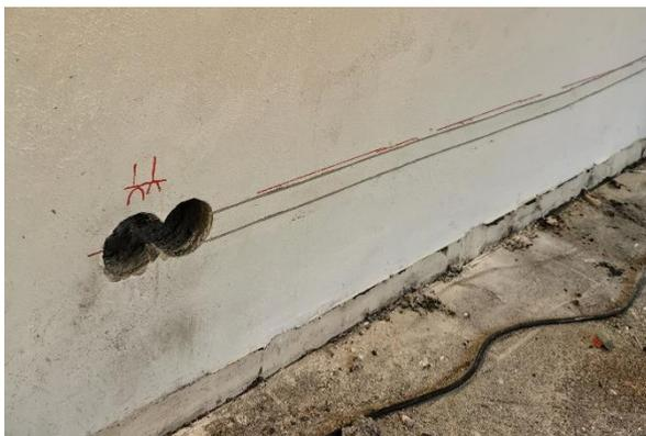
Wenn der Staubsauger angeschlossen ist kannst du anfangen entlang der angezeigten Linien zu fräsen.
