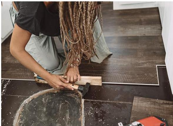
**Wichtig:** An den Stellen, an denen der Boden gestückelt werden muss, sollte die darauffolgende Platte wieder ein komplettes Stück sein, damit man maximale Stabilität bekommt.
